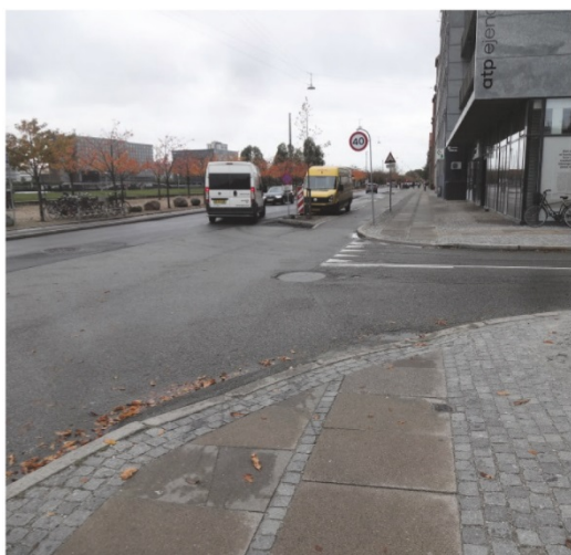
Figur 3.30 Eksempler på sideveje med vigepligt. Til højre er der etableret udvendig rampe, som er for stejl. (Islands Brygge, København hhv Aarhus).
