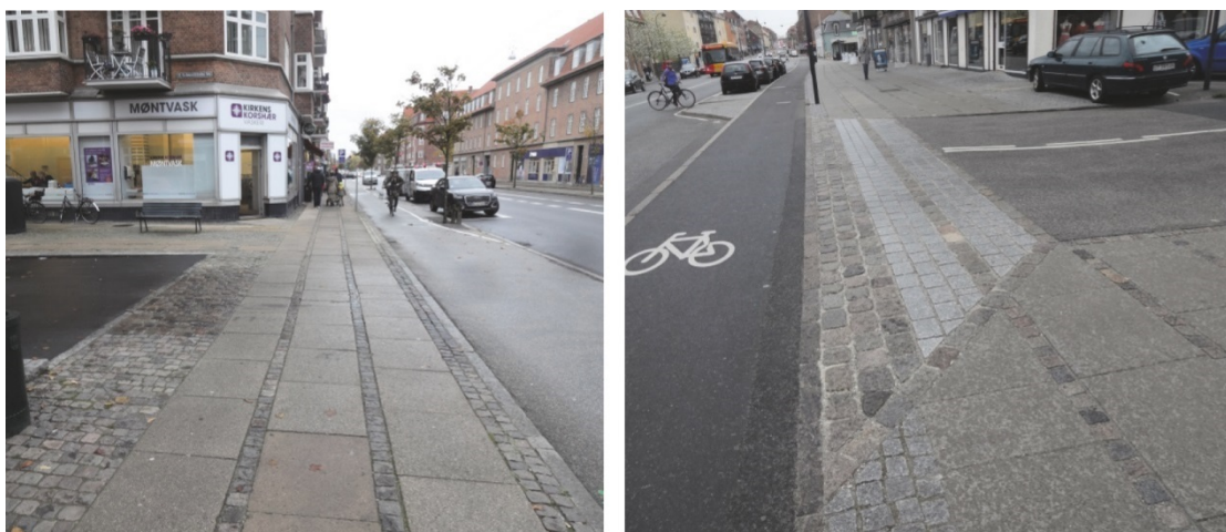
Figur 3.27 Eksempel på overkørsler. TV: Gangbanen er trukket forbi sidevejen i fuld bredde. (Frederiksberg Kommune). TH: Der er etableret en særlig belægning ud for sidevejen. Her burde gangbanen trækkes gennem overkørslen i fuld bredde. Der er ikke 80 cm sammenhængende jævn belægning. (Gladsaxe Kommune).
