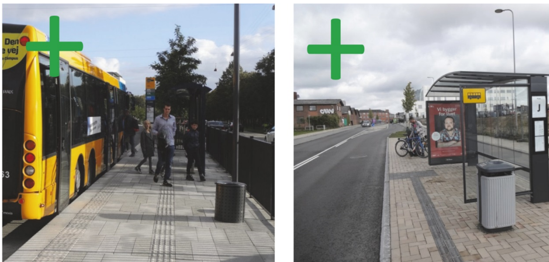
Figur 3.38 Til venstre: 17 cm høj kantsten giver lettere ind- og udstigning for alle. Nørre Campus, København. Bemærk taktil markering af sikkerhedszonen langs kantstenen, som anbefales ved BRT-stoppesteder. Farvekontrasten i ledelinjen er utilstrækkelig. Til højre: Busstoppested i Odense, der viser en række af elementerne i vejledningen.
