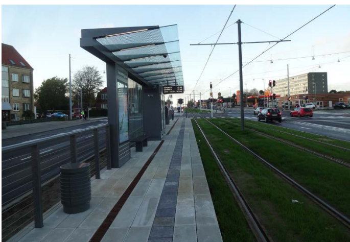
Figur 3.39 Letbanestoppested i Aarhus. Der er en taktil markering langs sikkerhedszonen udformet som et 30 cm bredt langsgående opmærksomhedsfelt, der erstatter ledelinjen. (Anbefalet bredde er her 56 cm). Pladsen er snæver ud for teknikrum.
