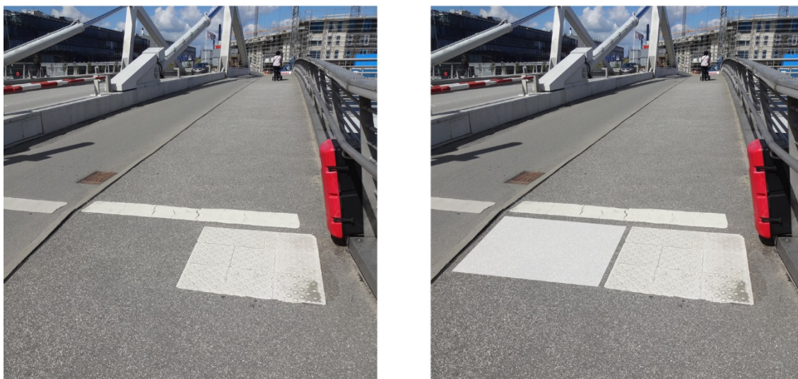
Figur 3.18 Opmærksomhedsfelt ved klapbro (Sydhavnen, København). Opmærksomhedsfeltet burde spænde i gangbanens fulde bredde (vist til højre). Broens værn udgør her den naturlige ledelinje.
