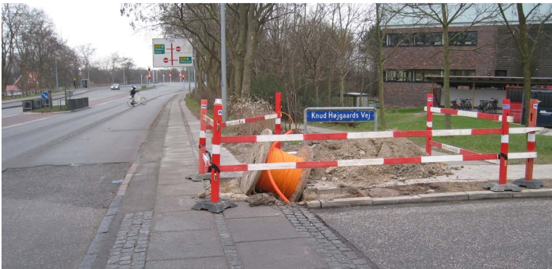
Figur 3.51 Afspærring under vejarbejde. Den viste løsning er ikke 100 % korrekt, da den nederste vandrette bom sidder for højt.
