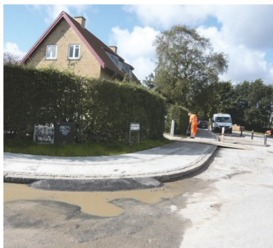
Figur 3.30 Eksempler på sideveje med vigepligt. Til højre er der etableret udvendig rampe, som er for stejl. (Islands Brygge, København hhv Aarhus).
