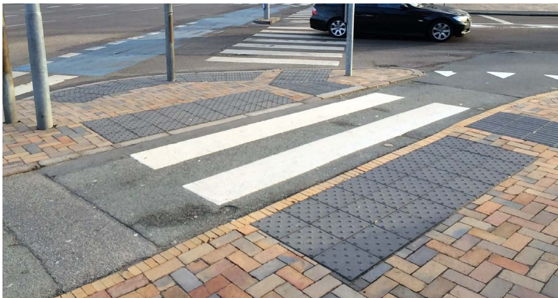
Figur 3.36 Eksempel på cykelshunt. Der mangler retningsfelt til venstre mod kørebane. (Foto Odense Kommune).
