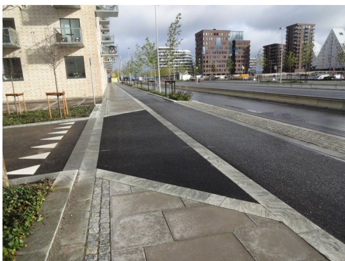
Figur 3.28 Asfaltoverkørsel (Bernhard Jensens Boulevard, Aarhus Kommune). En lille forbedring kunne her være at trække de 2 rækker chaussésten i venstre side igennem overkørslen.
