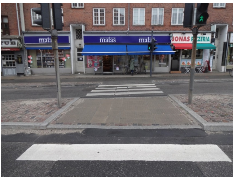
Figur 3.23 Eksempel på midterhelle, hvor der er niveauforskel mellem de 2 dele og asfaltrampe ud for 0-kantstenen. Der er her ikke farvekontrast mellem de taktile elementer og omgivelserne. Der er heller ikke 6 cm kantstensopspring ud for retningsfeltet, men 3-4 cm hvilket er i overensstemmelse med tidligere vejledning.
