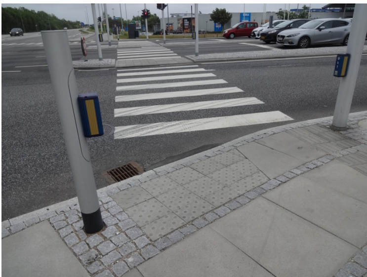
Figur 3.22 Trykknop i begge sider af fodgængerfeltet, så kørestolsbrugere ikke behøver at placere sig ved den høje kantsten. Der savnes kontrastfarve på opmærksomheds- og retningsfelt. (Aarhus)
